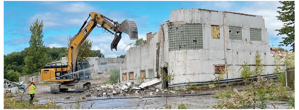
L'entreprise C.F.G. Construction inc. a débuté les travaux de démolition le 26 août et prévoit terminer l'ensemble des opérations vers le 20 septembre. (Photo : Michel Bédard)
