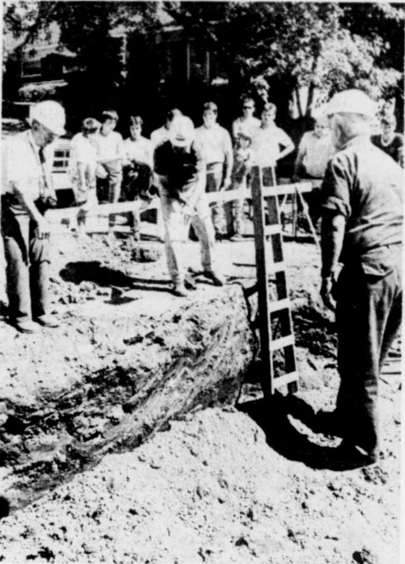
Au lendemain de l'accident, en juillet 1986, M. Robert Dupont, contremaître à l'emploi de la ville de Beauport, avait confié au SOLEIL que la municipalité s'attendait à être blâmée pour la mort de M. René Drouin, enseveli dans cette tranchée alors qu'il travaillait à la pose d'une conduite d'égout.
