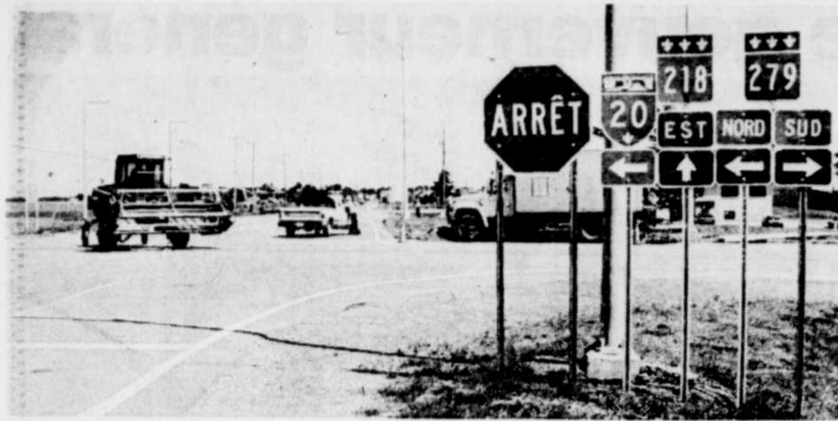
Les véhicules transportant de l'équipement aratoire, ou encore les poids lourds, ne peuvent s'engager rapidement sur la route 279. Un véhicule qui surgit en haut de la montée à 100 km/h dispose de peu de temps pour freiner. On prétend que l'arrêt obligatoire, placé près de quatre autres panneaux de signalisation, peu créer une confusion chez les automobilistes. Quoiqu'il advienne, des feux clignotants seront en place aujourd'hui ou demain.
