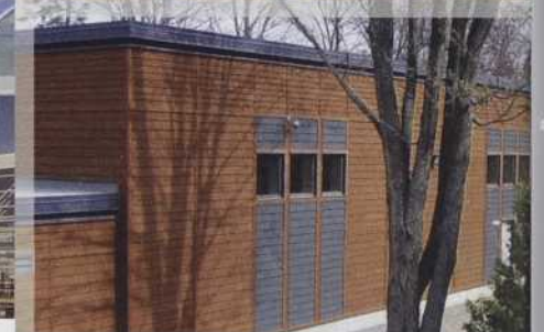
▲ Gymnase de l'école Vision, Québec Architecte: Claude Guy, architecte
