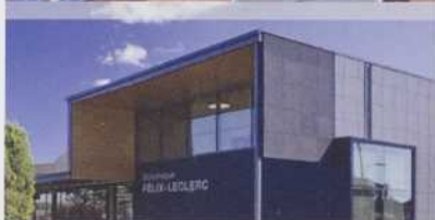
▲ Agrandissement de la bibliothèque Félix-Leclerc, Québec Architecte: Anne Carrier Architecte
