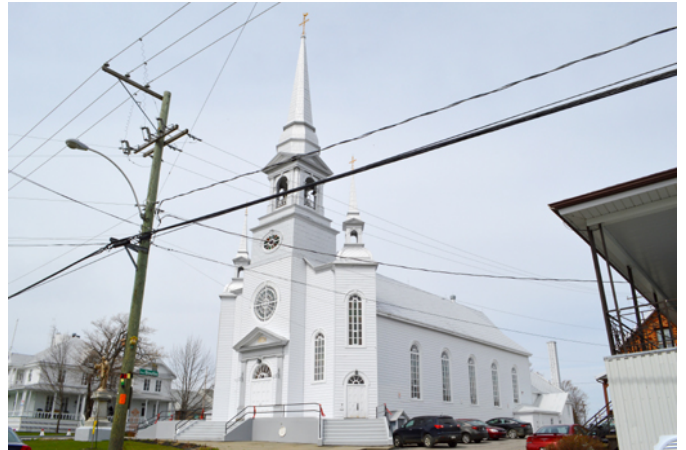
Église de Saint-Magloire, sise au 131, rue Principale
