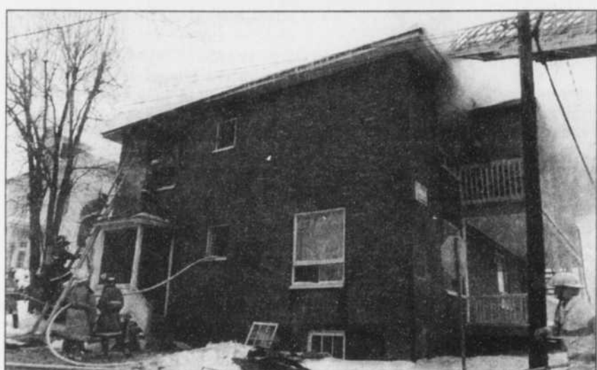
Les murs de la maison de chambres étaient isolés avec du bran de scie ce qui a permis au feu de se propager rapidement.
