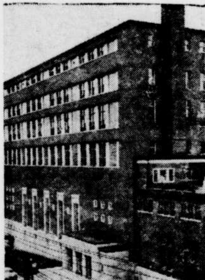
Entrée principale de l'Auditorium de l'Université de Sherbrooke, rue Frontenac.
