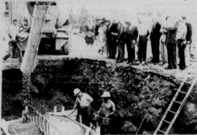
Mercredi avait lieu l'inauguration officielle du chantier du Moulin de la Tourelle. Une bétonnière a déversé sa première cargaison en présence de quelques personnalités. (Photo Le Soleil - Jacques Smith).
