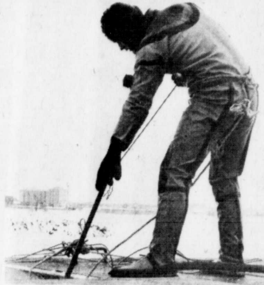
Avant de descendre dans la conduite, il a fallu que les plongeurs brisent la glace à l'entrée du puits. L'opération consistait à introduire un boyau transportant de la vapeur pour faire fondre le frasil.
