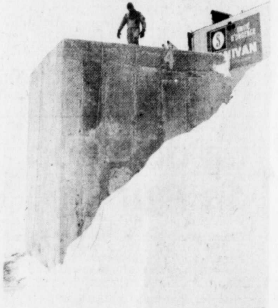
Il faut descendre dans un puits d'environ 60 pieds de profondeur avant d'atteindre l'eau de la conduite d'alimentation d'eau brute.
