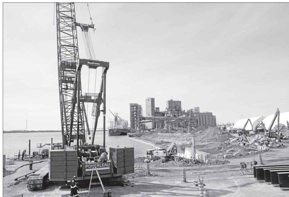
Différentes grues sont actuellement sur le chantier du port de Trois-Rivières. — PHOTO: SYLVAIN MAYER
