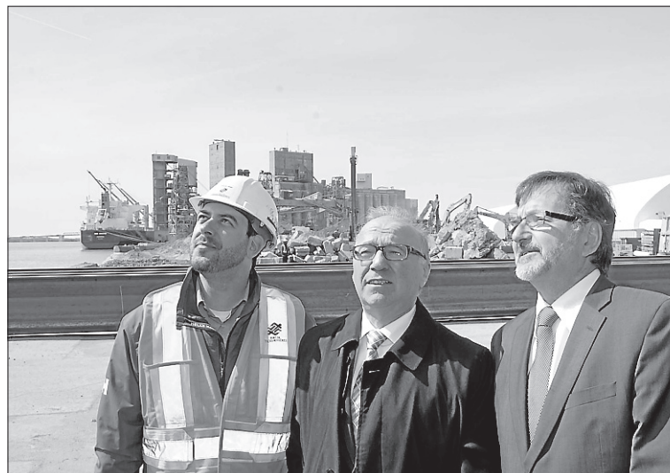
Steve Jean, directeur adjoint des opérations, Michel Parent, directeur des opérations, et Gaétan Boivin, président et directeur général, ont fait visiter le chantier en cours actuellement au port de Trois-Rivières. — PHOTO: SYLVAIN MAYER
