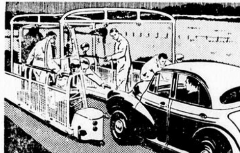
Cette cage mobile a été construite spécialement pour l'épreuve. Quand l'automobile entrait dans la cage les deux véhicules synchronisaient leur vitesse. Des mécaniciens refaisaient le plein d'essence et d'huile tandis que les chauffeurs se relayaient.
