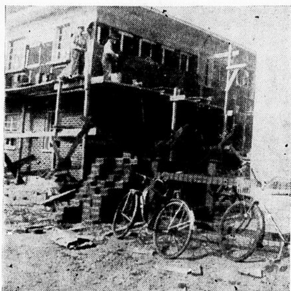
Pendant la construction
