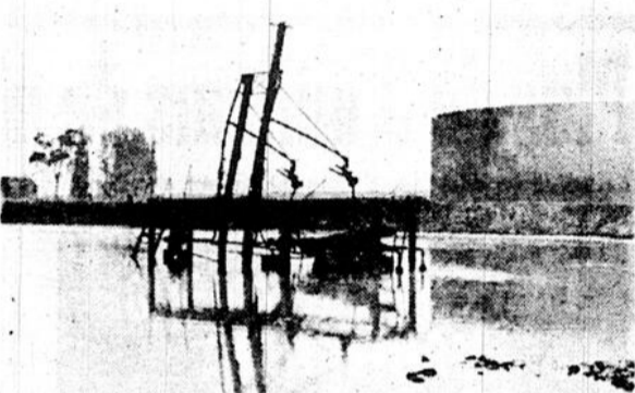
Les terrains de la Caléx ne sont plus qu'un lac avec, au centre, des pompes qui semblent prêtes à sombrer.
