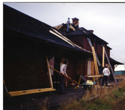
Réparation permanente de la toiture
