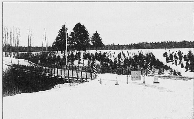
FERMÉ - Le pont de la rivière Ticouapé sur le 8e Rang Sud à Normandin est présentement fermé pour une période indéterminée.
