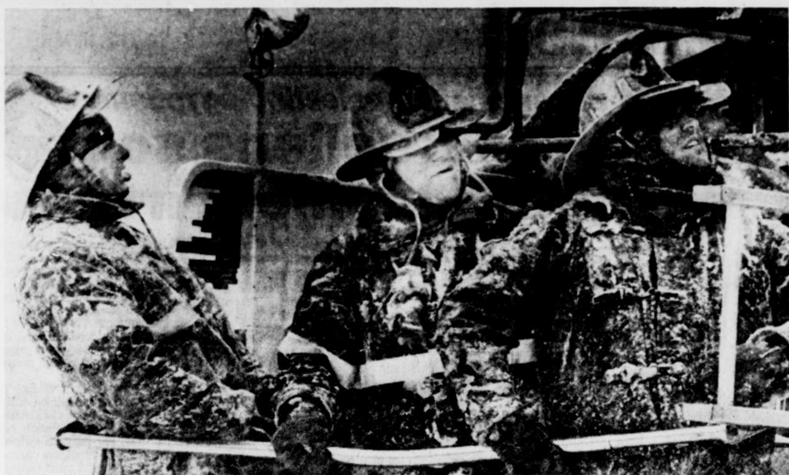
Le travail des pompiers s'est fait durant une forte tempête de neige.
