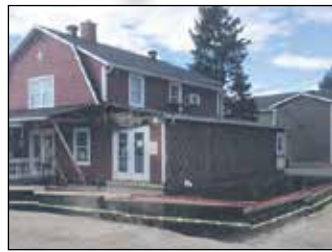
C'est le début des travaux pour le Café Noisette.
