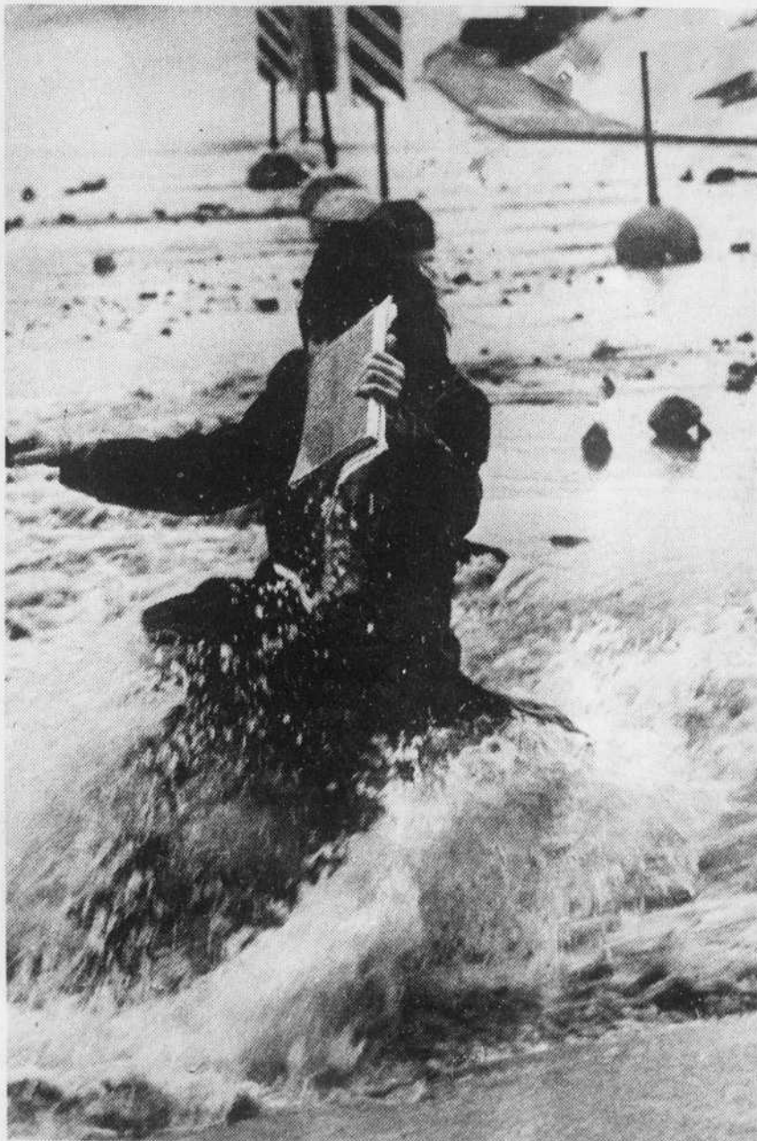
Ce jeune homme au parapluie traverse innocemment la chaussée McGregor, où une conduite d'eau éclata hier après-midi, peu avant l'heure de pointe. Deux pouces d'eau n'allaient pas l'arrêter! Mais le geyser en crachant des tonnes de boue dans la rue avait creusé une tranchée sous le torrent qui faillit bien emporter l'audacieux. Et puis d'ailleurs, il pleuvait déjà hier sur Montréal? (Photo Alain Renaud)
