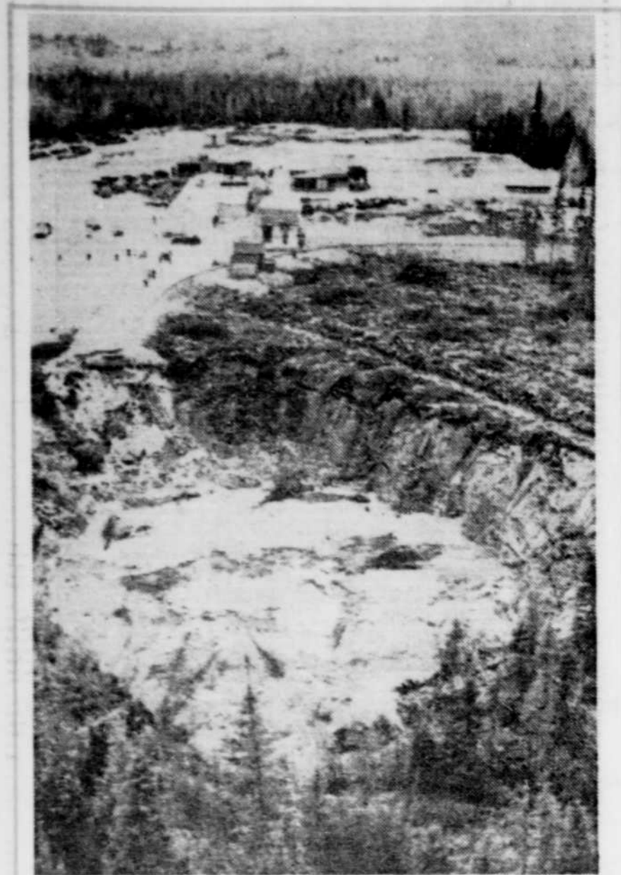
Cette photo aérienne nous fait voir l'effondrement qui est survenu mardi à proximité des bâtiments principaux de la mine Belmoral de Val d'Or. C'est dans ce trou que les huit mineurs sont pris au piège.
