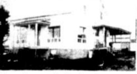
Bungalow situé à 140 rue Morissette, Princeville.
