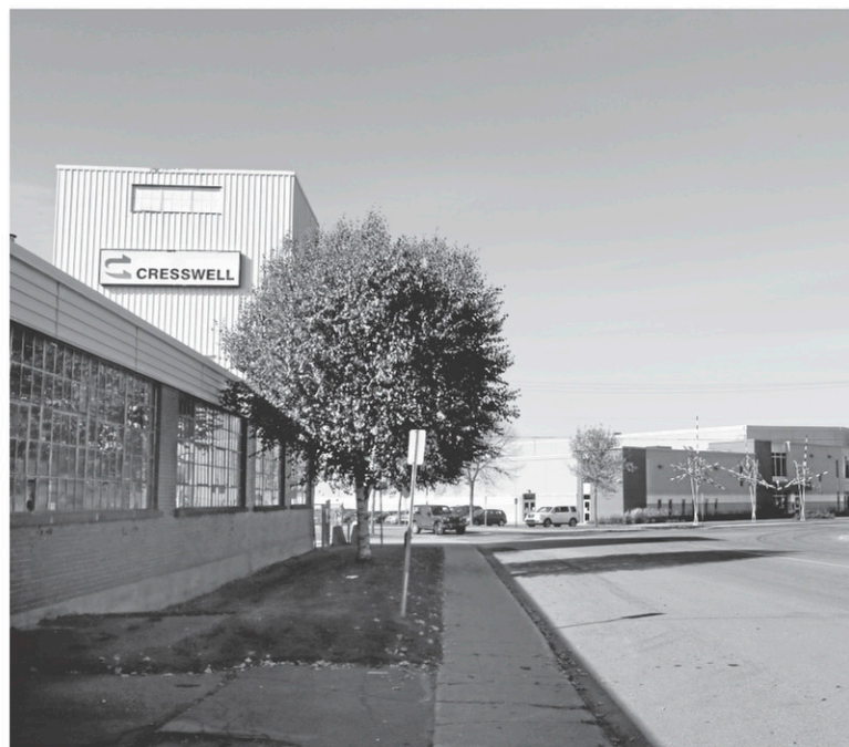
Le site des Industries Cresswell, rue Léon-Harmel, est dans la mire de la firme Médifice pour la construction du futur CHSLD à Granby. — PHOTO ARCHIVES LA VOIX DE L'EST
