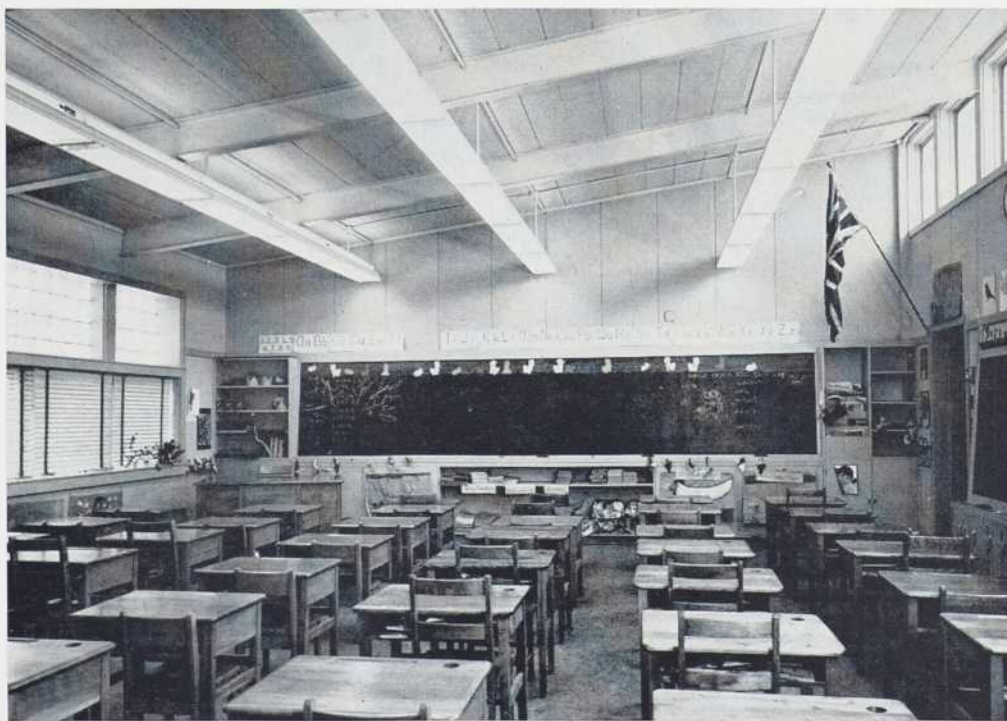
Une classe type du bloc en façade. Les classes comme celle-ci (Type "A") ont un éclairage naturel bilatéral. Des lampes fluorescentes pourvoient à l'éclairage artificiel.
