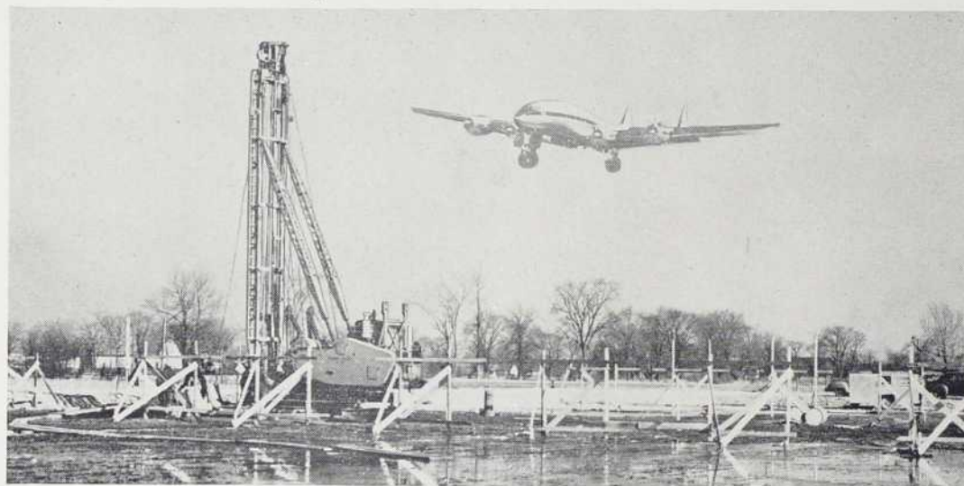
Machine Franki à l'œuvre sur le chantier de la Terminal Realty and Investment Corp., aux environs immédiats de l'aéroport de Dorval, Côte-de-Liesse, Montréal.
