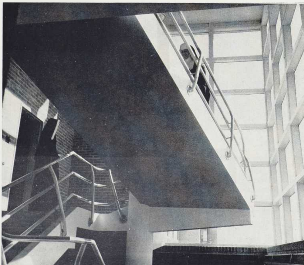
L'escalier en béton de l'entrée principale. On remarquera la rampe en tuyau d'aluminium, très gracieuse et jolie. Ce dernier matériau cadre bien dans l'ensemble de l'immeuble qui s'élève dans une région productrice d'aluminium.
