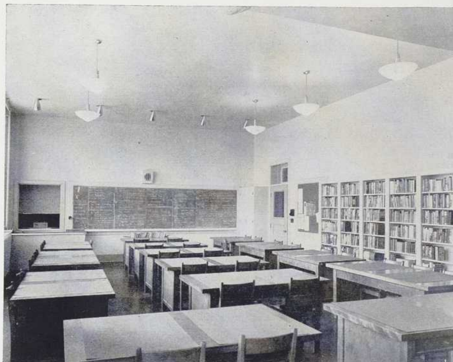
Classe éclairée avec des luminaires indirects, type "glass bowl". Aucun éblouissement possible avec ce genre d'éclairage. A noter les 5 projecteurs qui ont pour fonction d'éclairer le tableau.
