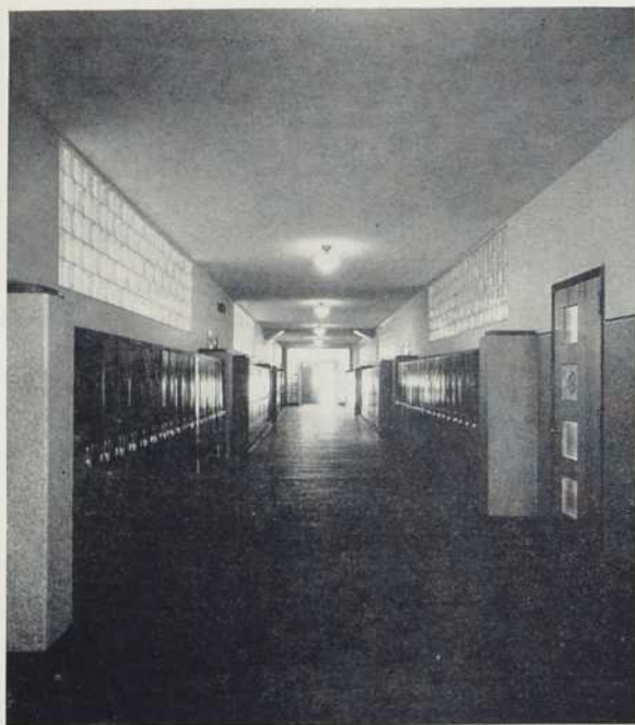
Un corridor type. Au fond, éclairage de la cage d'escalier en blocs de verre. Casier en métal tout le long du corridor.
