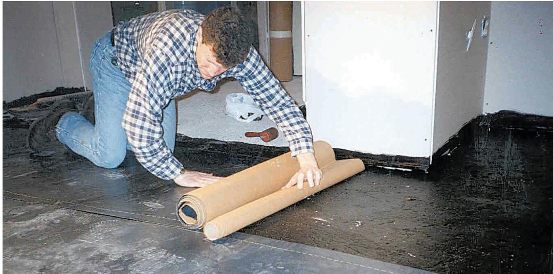
Les membranes élastomères autocollantes ont de multiples fonctions, comme rendre étanche un plancher de sous-sol.
