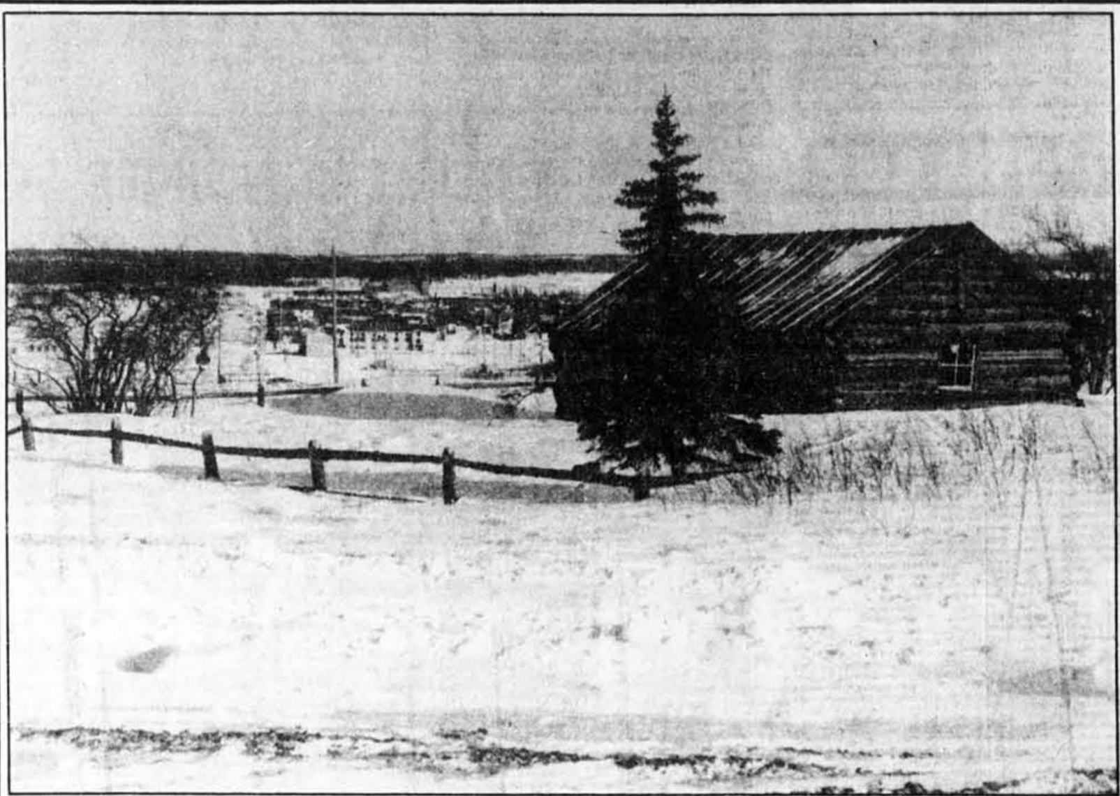
Ce qui reste de la ville de Schefferville.
