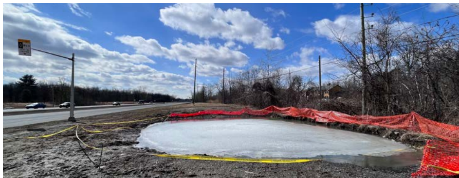
C'est à cet endroit que Vidéotron érigera une antenne de télécommunications. (Photo : Frank Jr Rodi)
