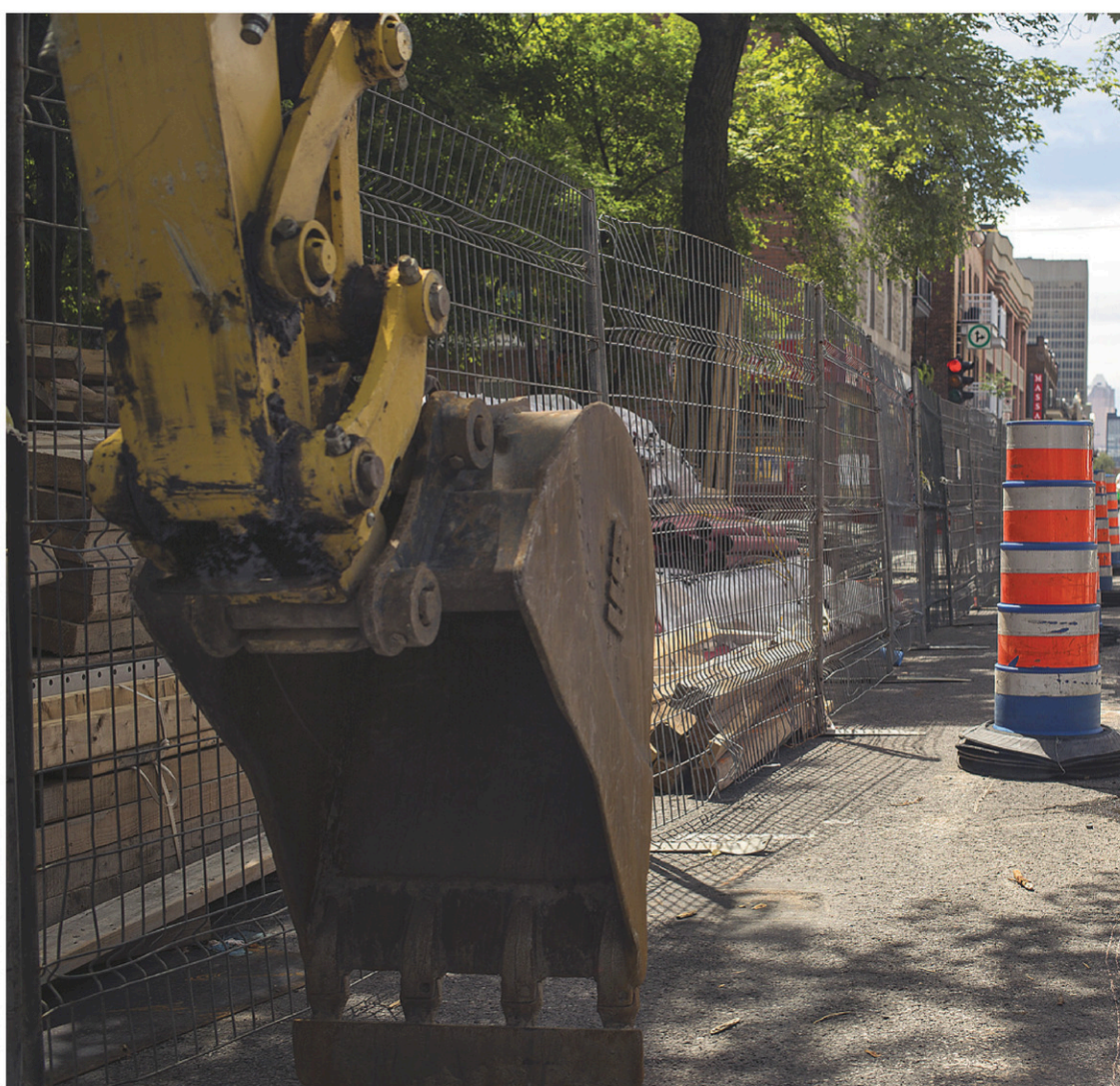
Lancé en 2007, un plan d'action de la Ville de Montréal prévoit de remplacer toutes les entrées de service en plomb (ESP) de son réseau d'ici 2026.
