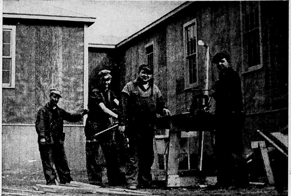
Nous voyons sur cette photo un groupe de plombiers employés aux travaux de tuyauterie pour les baraques militaires de Valleyfield. Aujourd'hui, tout est presque complet et le nivellement du terrain se fera graduellement. Les
