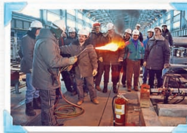
Allumage du premier brûleur au four à cuisson des anodes.
