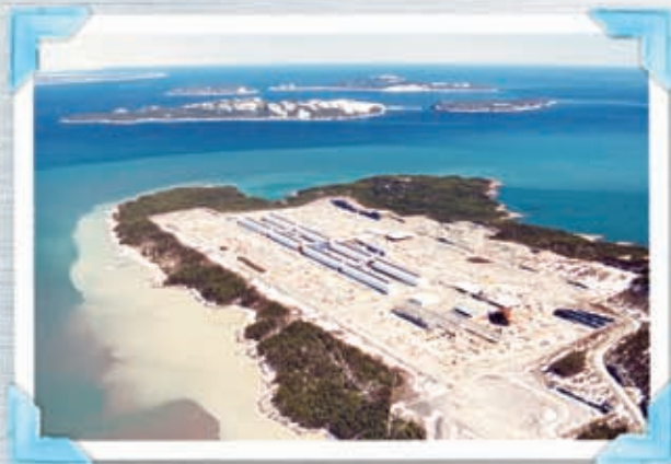
Avril 1991, la construction d'Alouette est bien amorcée.
