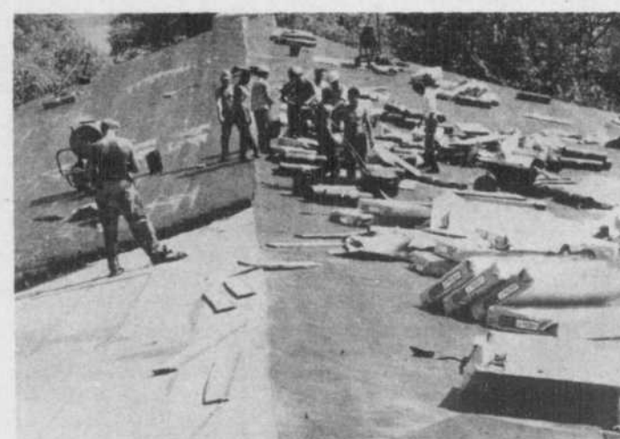
Un vrai toit remplacera le toit de toile.
