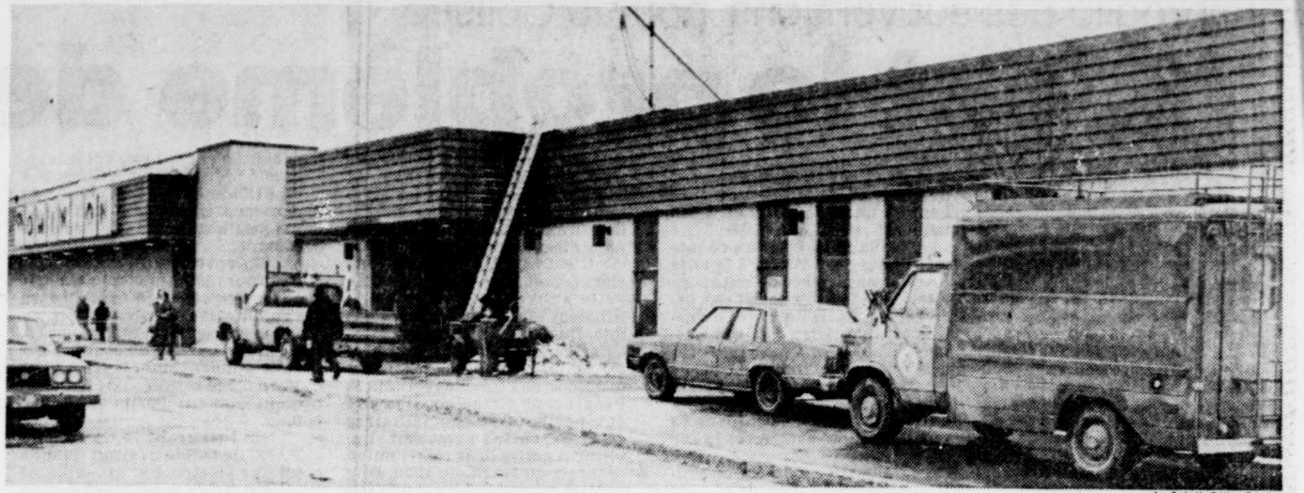
Dès hier après-midi, le toit était réparé au centre commercial Les Galeries Chagnon à Lévis. Pendant que la police continuait son enquête, les curieux se faisaient nombreux.
