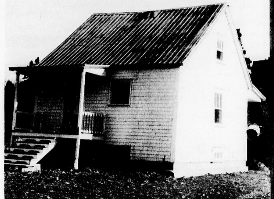
Pour faire de cette maison un kiosque touristique régional, le Cercle des Affaires de La Pocatière compte recueillir 20 000 $ dans la région. Jusqu'à maintenant, un peu plus de 6 000 $ ont été amassés.
