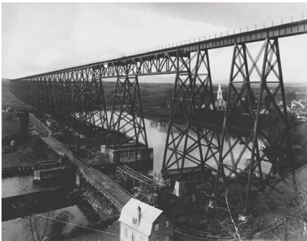
Figure 180 - Le pont ferroviaire de Cap-Rouge
