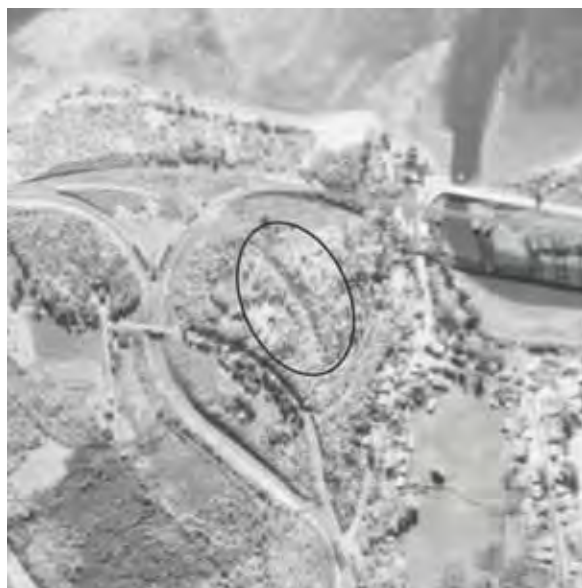
Figure 179 - Vue aérienne de la tranchée de la Canadian Northern Railway en 1949
