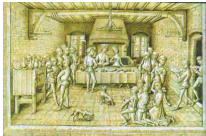
Figure 297 - Grande salle avec cheminée au mur
