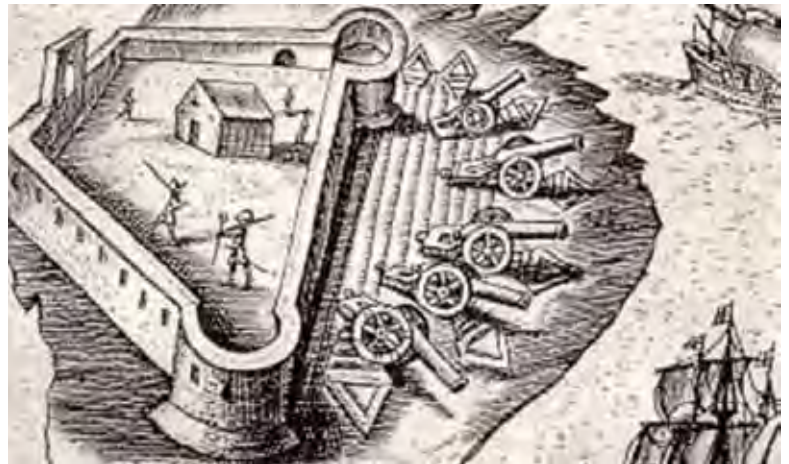
Figure 263 - Corps de garde et enceinte, défense maritime, fort Smith, Bermudes, début XVII e siècle
