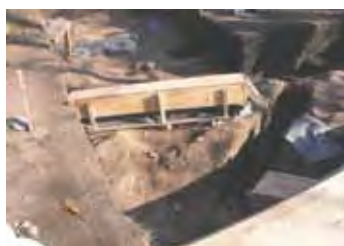
Coffrage sur une pièce de bois en place dans l'opération 65 © Philippe Slater, CCNQ
