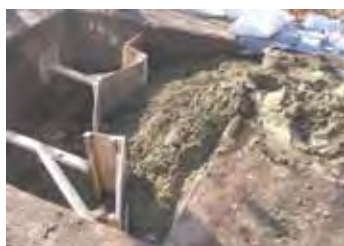
Étançonnement et ensablement du massif de pierres dans l'opération 43 © Philippe Slater, CCNQ
