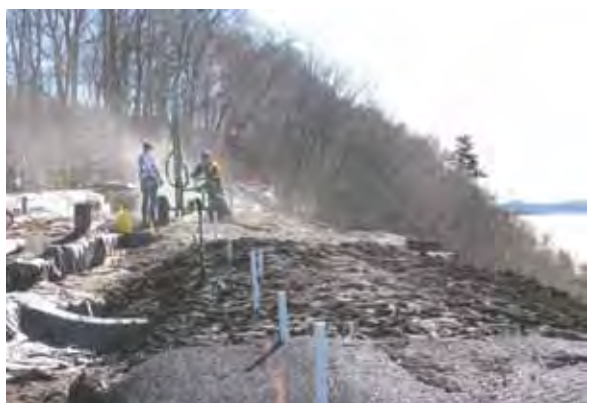
Forage des ancrages de la géogrille. © CCNQ, Mônica Bittencourt
