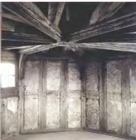
Figure 309 - Intérieur de tour, pan de bois avec torchis
