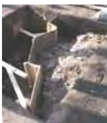
Étançonnement et ensablement du massif de pierres dans l'opération 43 © Philippe Slater, CCNQ
