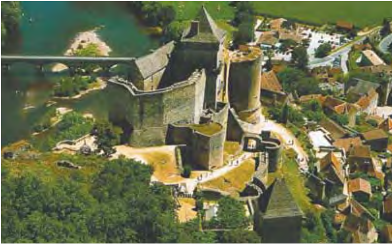
Figure 240 - Chemin de ronde sur l'enceinte en maçonnerie, butant sur une tour et au corps de logis, château de Castelnaud, XII e -XVI e siècles, Dordogne
