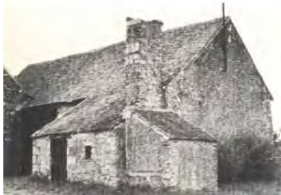
Figure 201 - Four à pain avec cheminée, Maine-et-Loire
