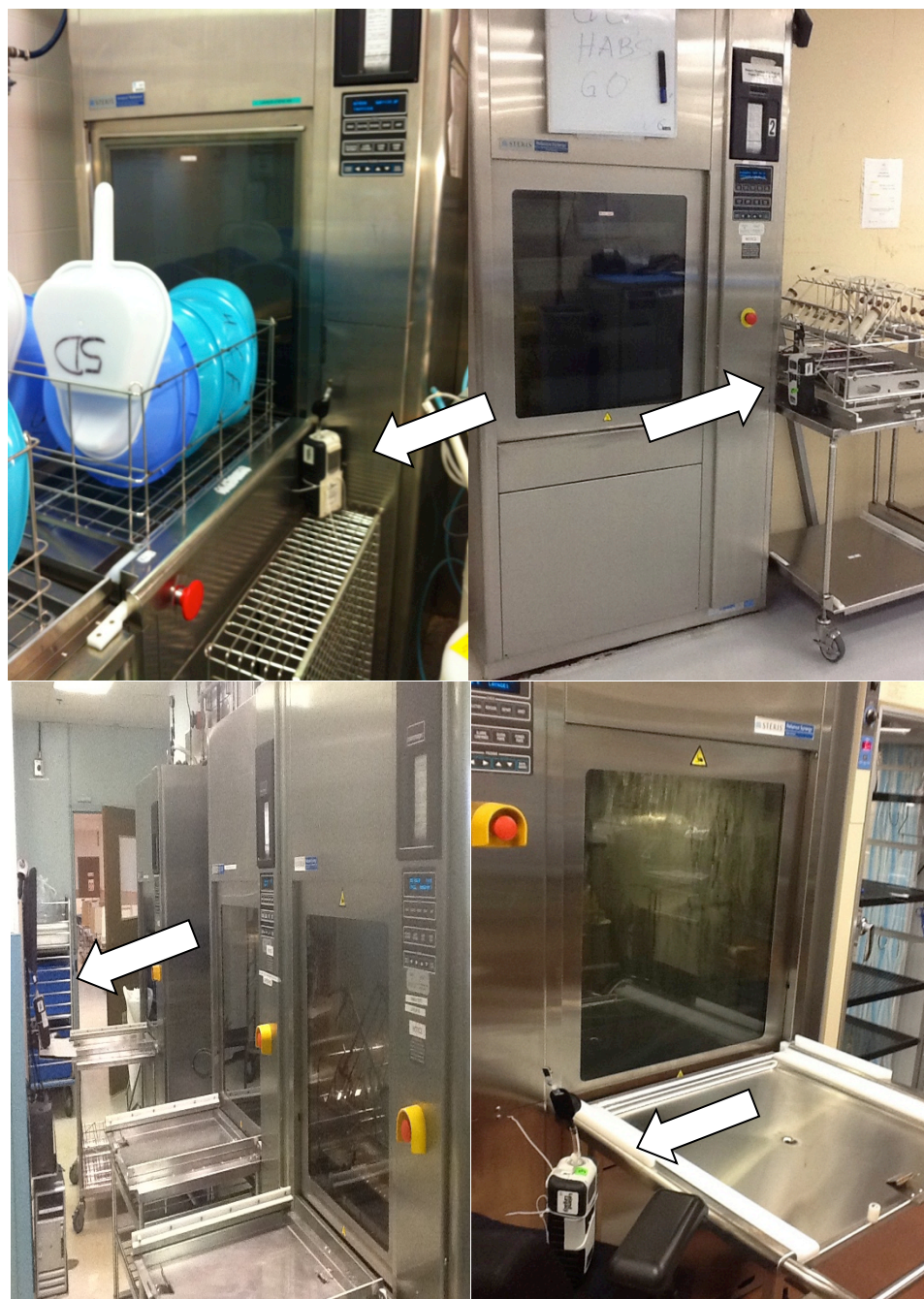
Photo 2 : Emplacement des pompes de prélèvement près des laveurs automatiques.
