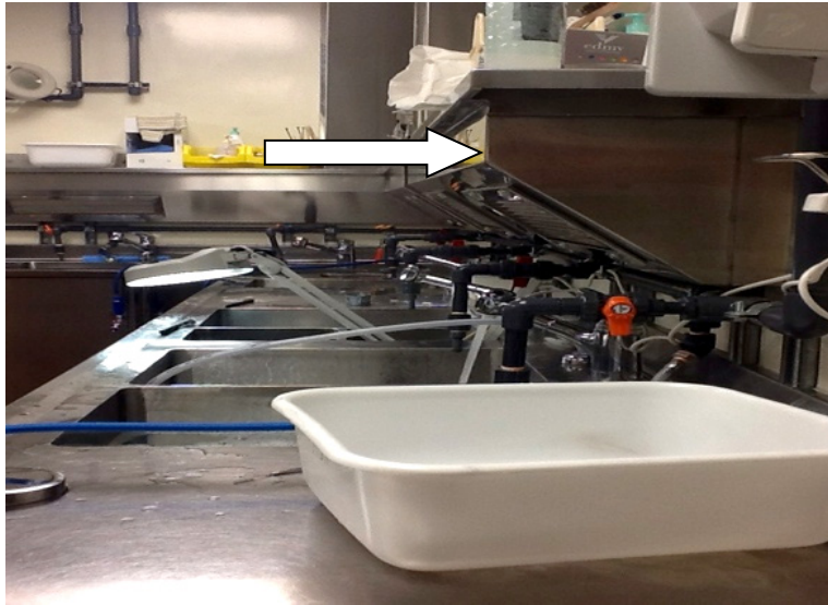
Photo 1 : Captation à la source utilisée au-dessus des évier lors des premières étapes de décontamination. La flèche indique l'emplacement du capteur d'air.
