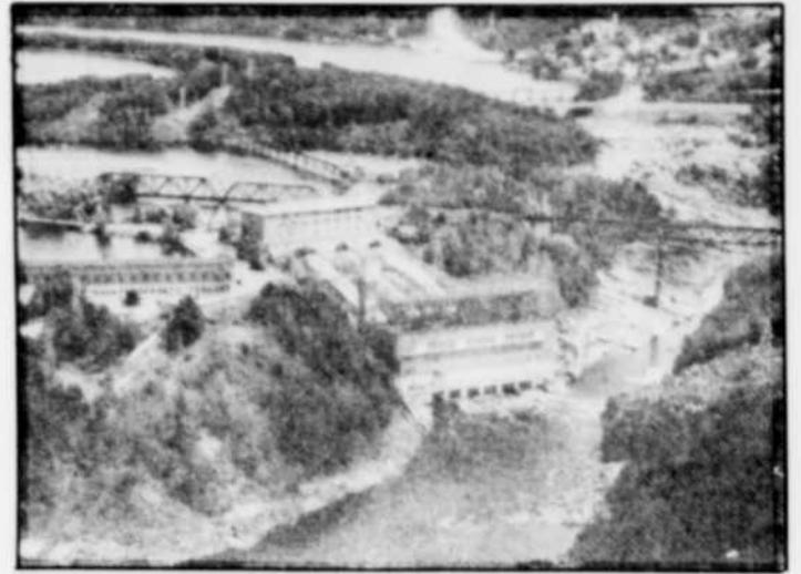
A gauche, la centrale Shawinigan 2 d'Hydro-Québec
