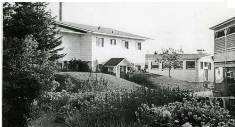
À gauche : la maison du noviciat : cellules, salles de conférence et de travail. Au centre : l'atelier d'ébénisterie, à droite la galerie grillagée de l'ouvrier. Source : Les Moniales Bénédictines de Mont-Laurier
