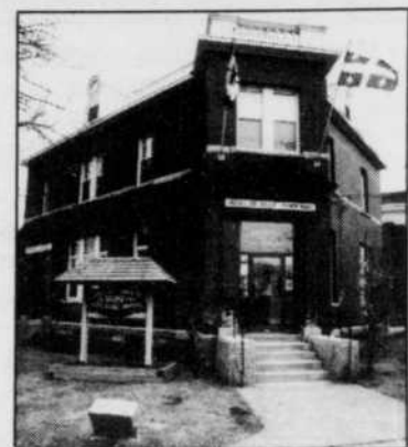
Construit en 1904, l'édifice actuel de l'hôtel de ville abritait à l'origine le bureau de poste. L'hôtel de ville et le poste de police y emménagèrent en 1973. de 10 h à 18 h le samedi et de 11 h à 18 h le dimanche. Des rafraîchissements et de légers repas seront disponibles à l'étage. Bienvenue à tous !
