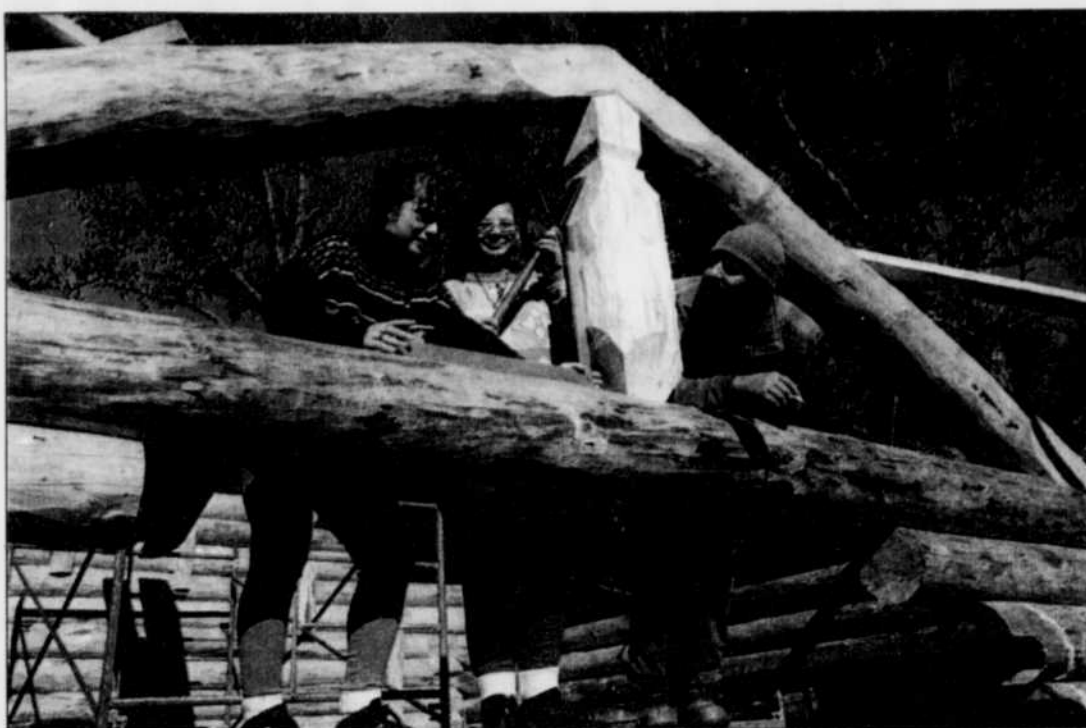
Jérôme Bouchard, de Saint-Urbain, est le grand maître d'œuvre de la construction d'un bâtiment en bois rond selon la technique scandinave, pour héberger les bénévoles dans le parc de la Jacques-Cartier. Ci-contre, il explique à Chrystel Ordonneau (extrême gauche) et Céline Huchet comment signaler la poutre centrale qui supportera le toit en sculptant la pièce de bois rond.
