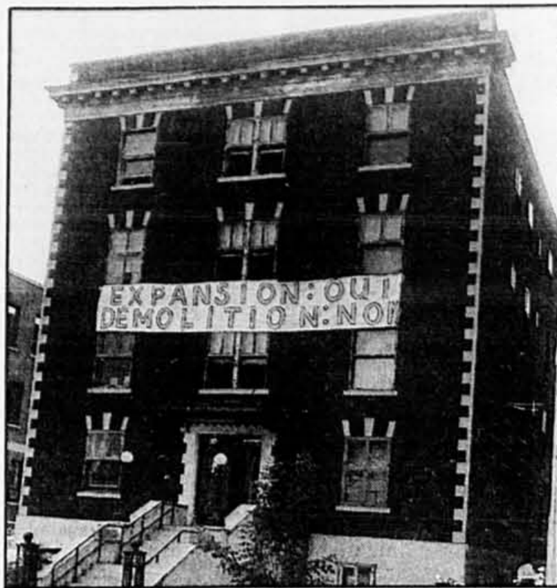
La conciergerie Dudley, du 3680 rue Saint-Urbain, le 9 septembre 1986, lorsque ses locataires et divers mouvements de protection de l'environnement voulaient en empêcher la démolition. Dans un revirement de situation, la municipalité vient d'accorder à l'Institut de recherches cliniques de Montréal le droit de procéder à la démolition.
