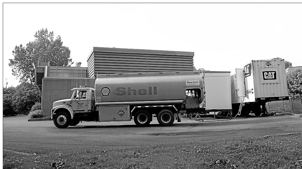
Des travaux d'urgence à la station de pompage de la rue Pinard auront coûté plus de 270 000 $, dont 44 553 $ pour la location d'une génératrice et 169 013 $ en carburant diesel coloré.
