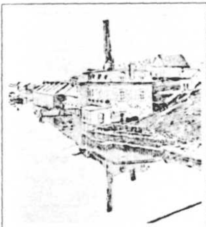
Le Saint-Maurice a aussi débordé et inondé partiellement les bâtiments de l'aqueduc.
