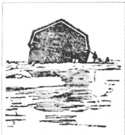
Cette maison de la rue Saint-Philippe a été emportée par l'inondation du Saint-Laurent.
