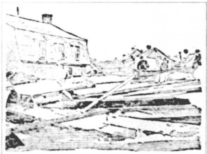
La débacle s'est abattue d'un seul coup sur une quinzaine de maisons de la rue Notre-Dame qui ont été culbutées et démolies par la glace.
