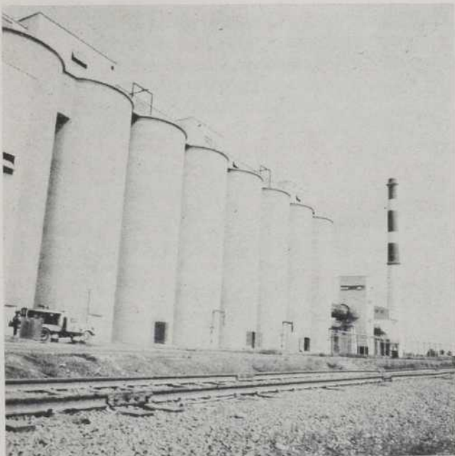
Les silos de stockage.
