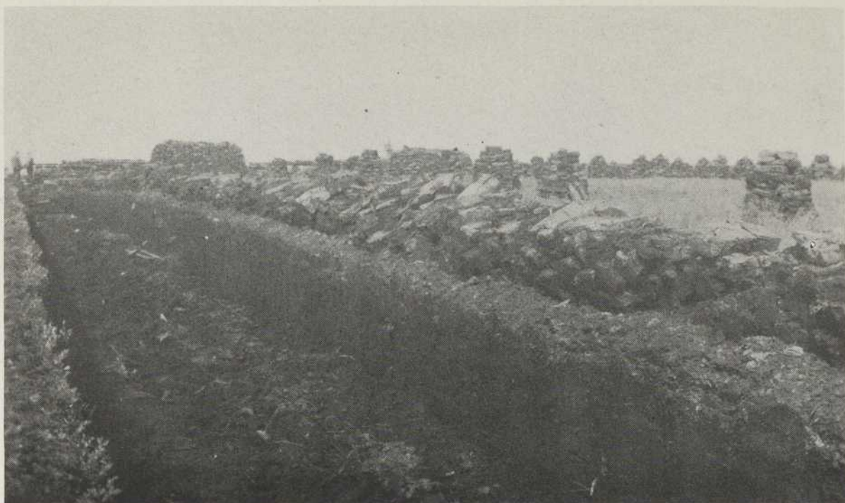
Pl. VIII—Mottes de tourbe mises en rangs sur le revers de la tranchée d'exploitation. Premier Peat Moss, Limited, tourbière de l'Ile-Verte.
