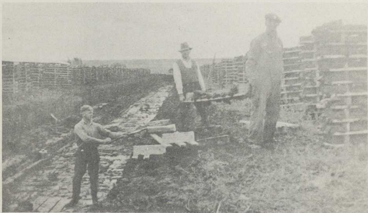
Pl. VII—Erection d'une étagère de séchage à la Canqda Peat, Limited, tourbière de Rivière-du-Loup.
