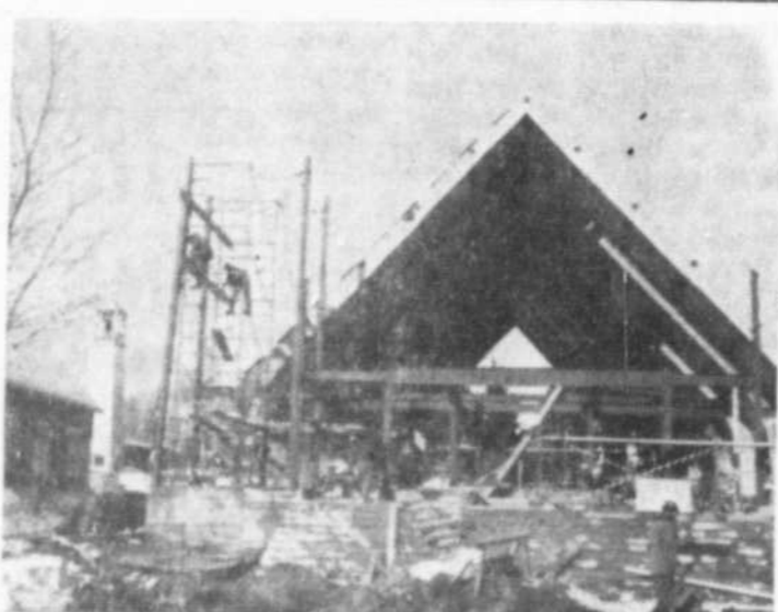
Photo prise pendant la construction. Les travaux, commencés à la fin de l'automne 1958, se continuèrent sans arrêt jusqu'au printemps.
