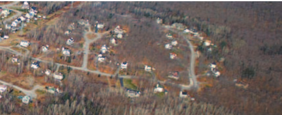
Vue aérienne de la rue Clos-des-Artisans et de la rue Clos-du-Meunier dans le quartier des Clos prévostois.
