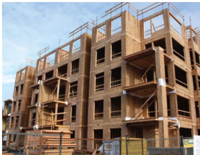
Figure 1 : Exemple de bâtiment à ossature légère en bois en Colombie-Britannique 26
