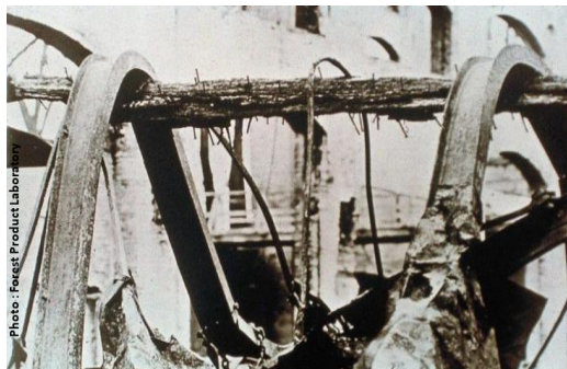
Figure 5 : Poutre de bois soutenant une poudre d'acier lors d'un incendie 58
