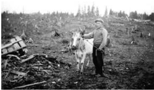
Une scène typique du défrichage et dessouchage des terres par les premiers colons. Cette photo à été prise dans la région de la paroisse de Saint-Patrice.
