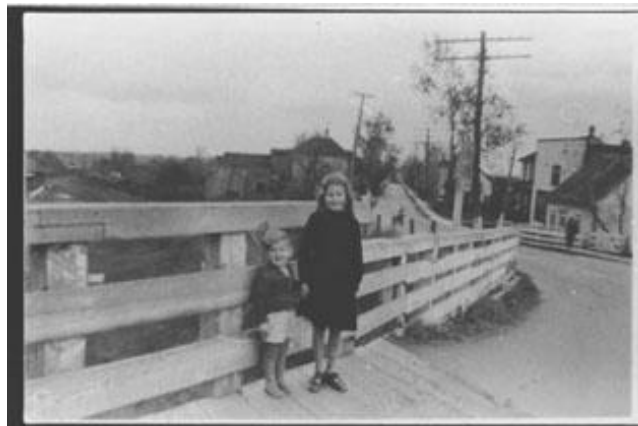
Viaduc au-dessus du chemin de fer, la route du Pont, vers 1932 Photo 462 – SPHSL
