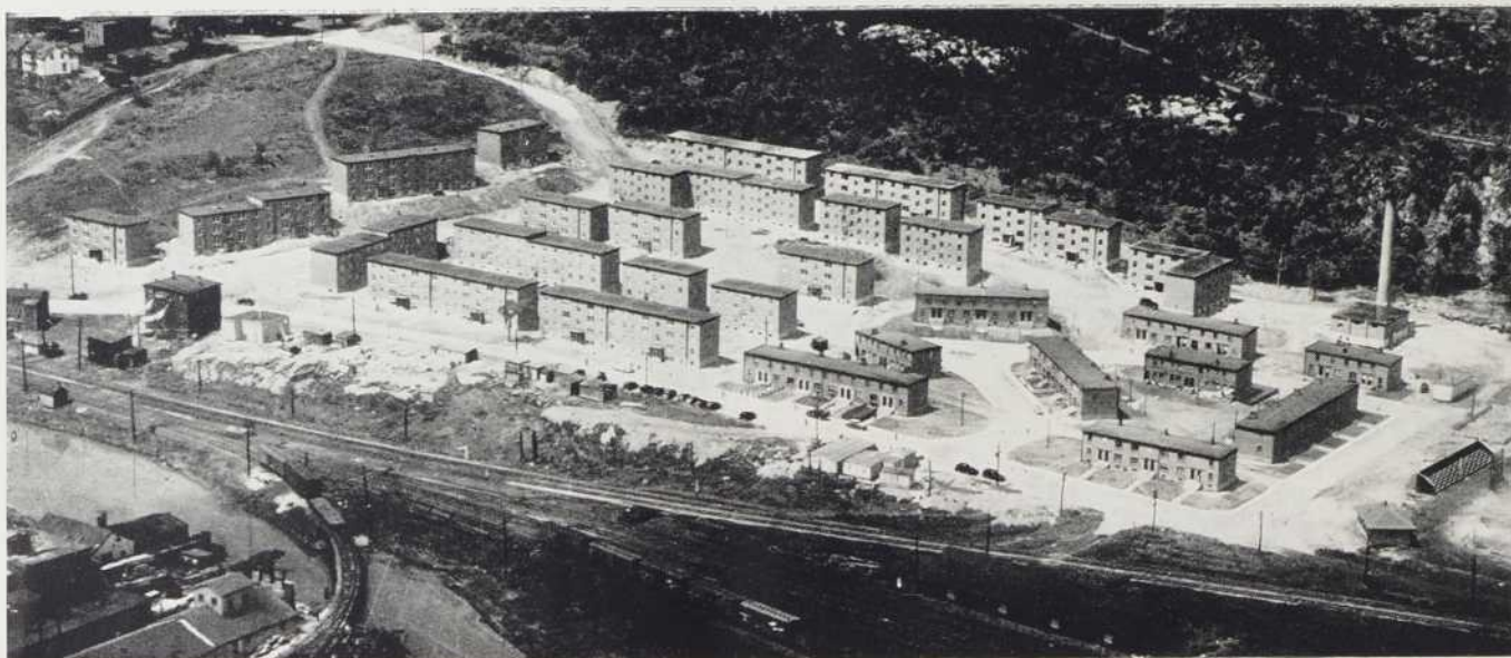
Ce projet de maisons modernes renferme 205 logis — Rockwood Court, Saint-John, N.B. Le système de chauffage "Monoflo" est installé. Dessiné par le service d'architecture de la Centrale d'Hypothèque et de Logement. Contracteurs en chauffage—Hagen & Company, Halifax, N.-S.
