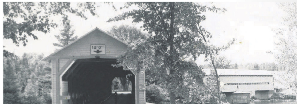
Les ponts couverts de la Ferme-Rouge, construits en 1903, sont les seuls ponts couverts jumelés encore existants au Québec. Parmi les noms des quatre bâtisseurs du plus petit pont, figure celui d'Évrard Touchette, « ouvrier décédé en ce lieu ». (Photo gracieuseté - Coll. SHGHL)
