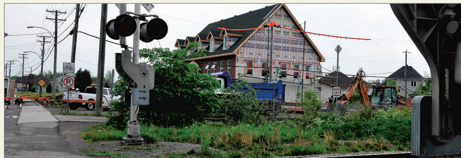
La construction de la garderie sur la rue Charles près de la voie ferrée sera bientôt complétée. PHOTO TC MEDIA - ERIC MONDOU
