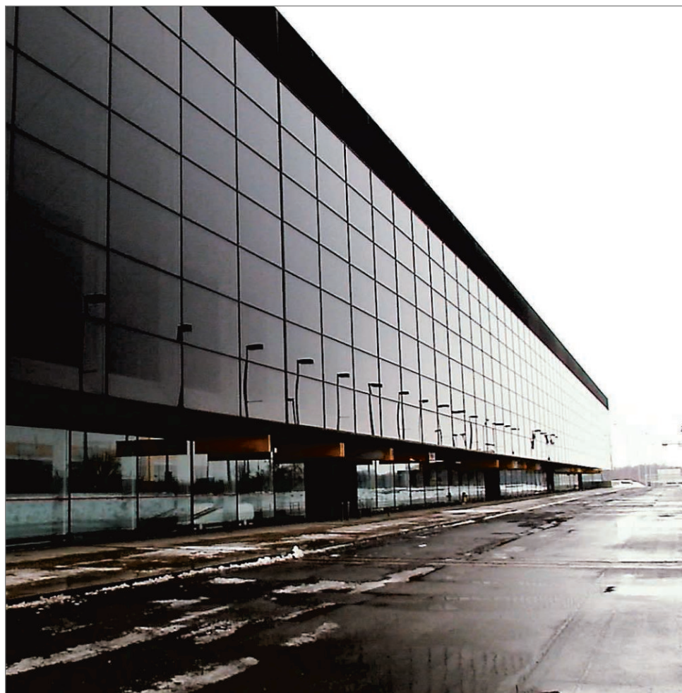
Les députés de la CAQ s'opposent à la démolition de la gare. PHOTO D'ARCHIVES
