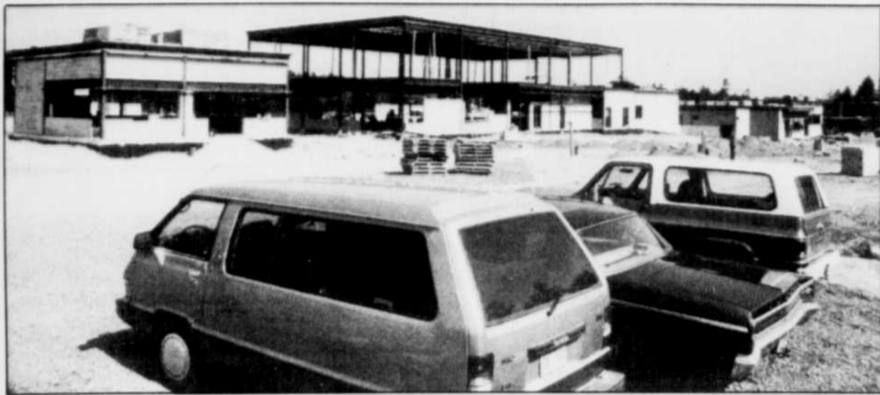
Sur notre photo, on commence à voir la structure d'un pavillon du nouveau centre de détention de Trois-Rivières.
