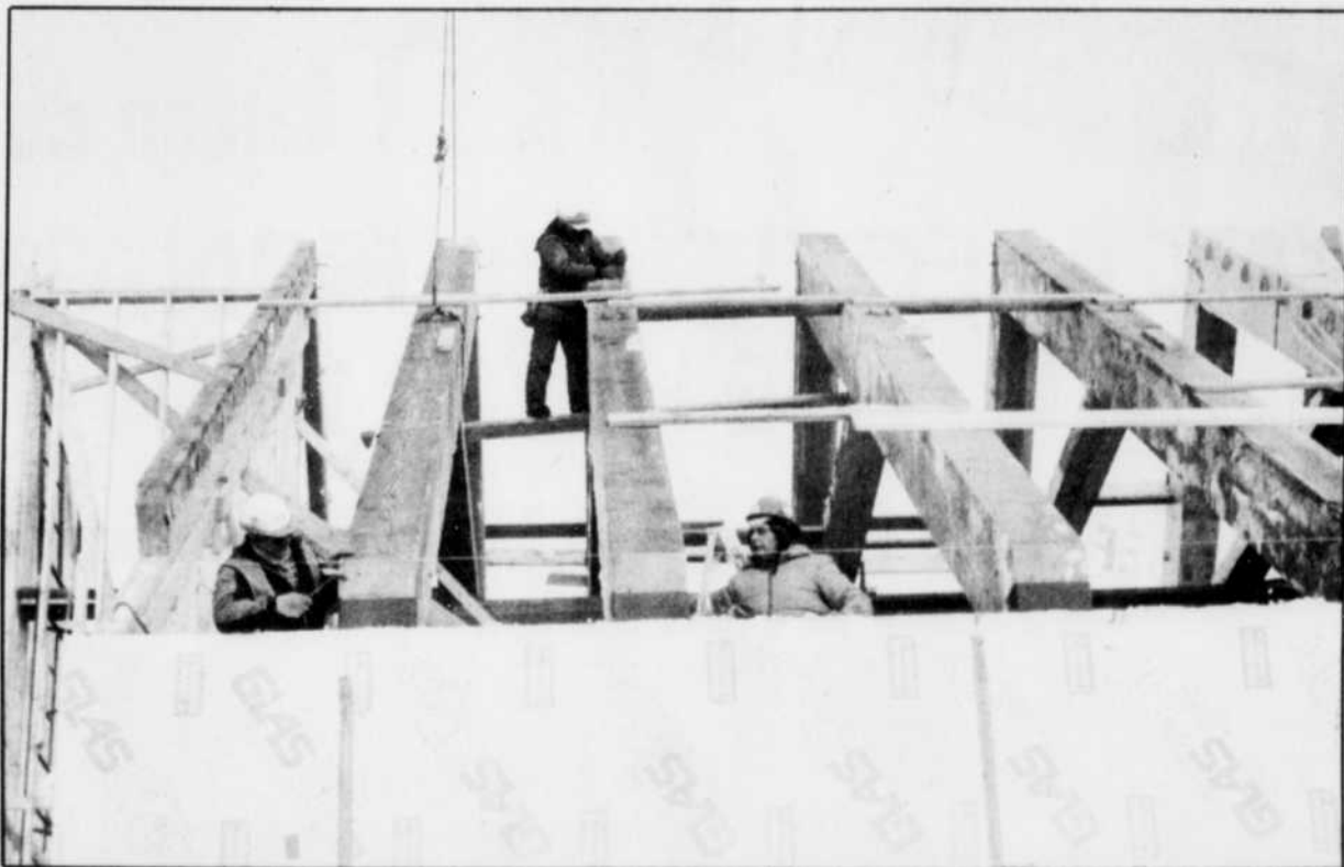
Les ouvriers installent les fameuses fermes de toit, qui supporteront le toit cathédrale de la Grande Maison.
