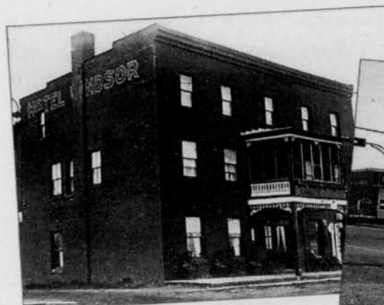
Anciennement l'Hôtel Windsor, maintenant l'hôtel de ville.
